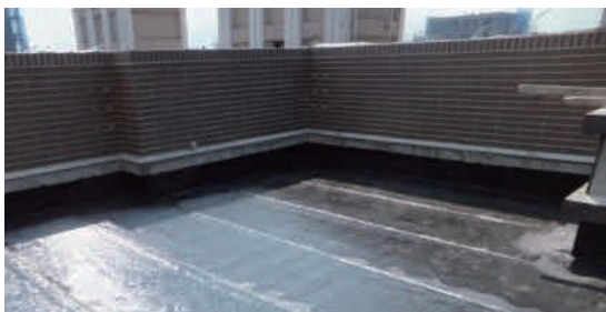
圖說：防水區域及工法展示，試水工程展示及頂樓景觀展示
