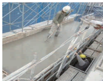
圖說：樓板灌漿前的施工工法展示及氯離子測試及水泥砂漿坍度測試等
