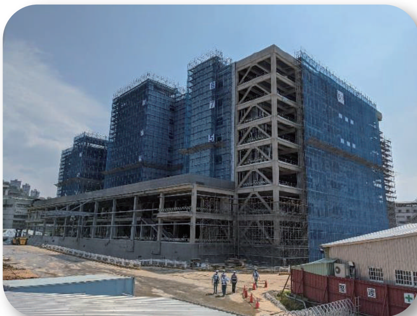
新北市新店區寶高智慧產業園區統包工程
