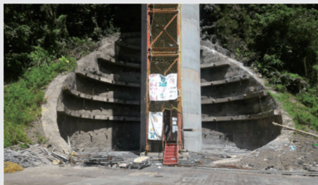
竹削工法於橋墩施作
