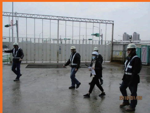
董事長巡視桃園A19建築工程
