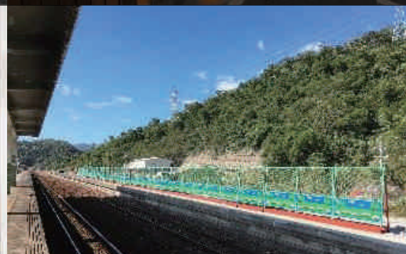
軌道施工護欄區隔
