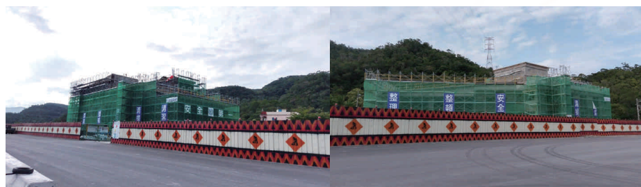
台9線C4標工程： 交控中心施工外觀照片
