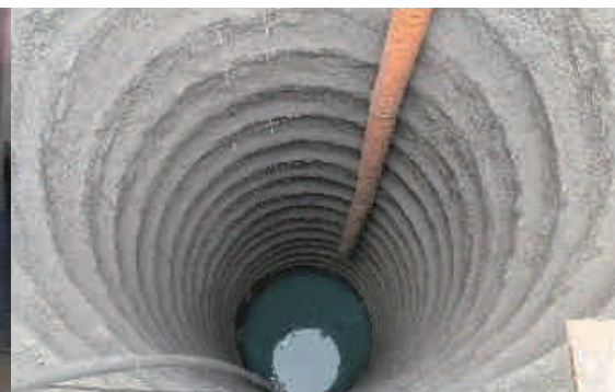
局限空間通風管延伸工作面
