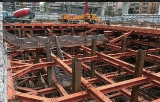
開挖階段架設擋土支撐
