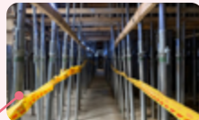
施工區域設置安全通道
