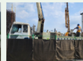
大型機具設置隔音裝置
