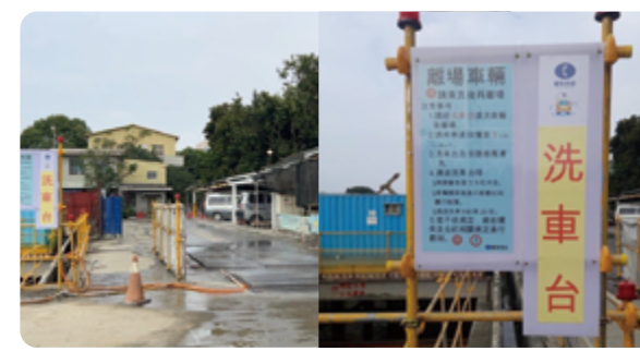
▲ 設置洗車台降低路面髒汙
