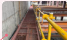
安全支撐上方設置安全通道
