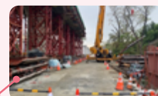
施工機具作業區(迴轉半徑)圍管
