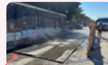
工區出入口設置洗車台及沉澱池
