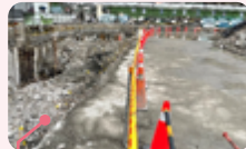
施工作業區區隔警示線
