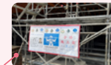
施工架檢查及指派合格作業主管
