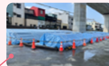
規劃專區分類堆置及區隔圍管
