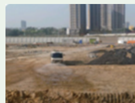
工區內灑水及抑制揚塵
