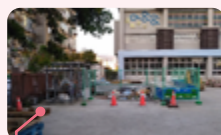
物料堆置區區隔及警示線
