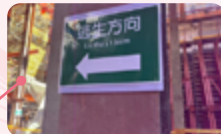
張貼適當且充足的職安宣導安全標示牌
