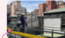
施工架搭設使用扶手先行框工法施作
