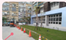
施工作業區區隔警示線
