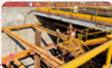
施工作業區設置安全上下設備
